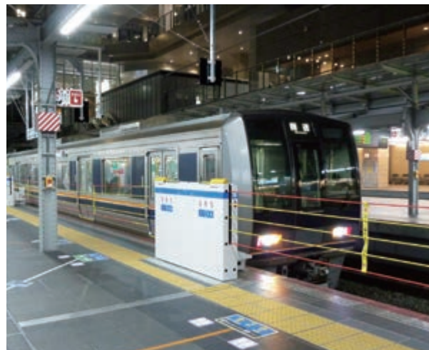
昇降式ホーム柵の例（大阪駅 JR京都・神戸線ホーム）
