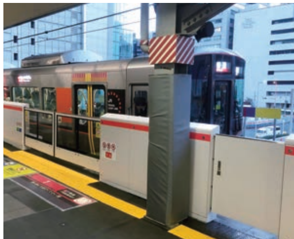
可動式ホーム柵の例（大阪駅 大阪環状線ホーム）
