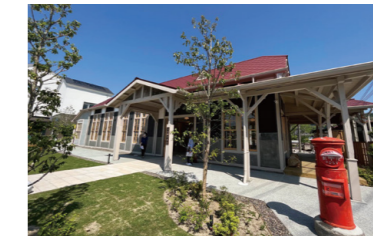
紀勢線湯浅駅旧駅舎を和歌山県湯浅町へ譲渡し、駅ホームの一部をカフェスペースにする等のリノベーションにより新しい街の拠点、人の集まる空間を創出しました。
