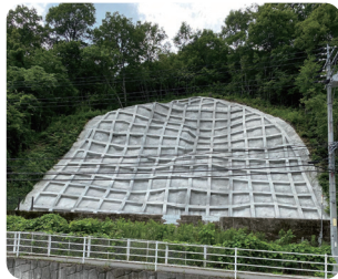
沿線の斜面の補強
