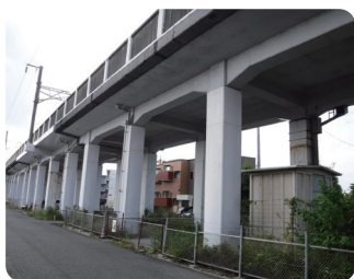
高架橋柱耐震補強
