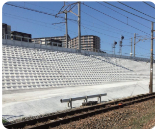
盛土区間の補強
