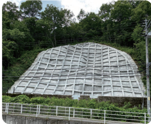
沿線の斜面の補強
