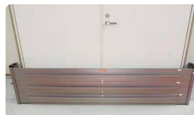
信号機器室入口に設置した止水設備
