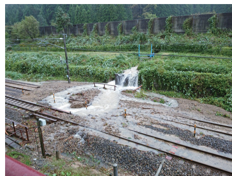
北陸線今庄～湯尾駅間 局地的豪雨による土砂流入
