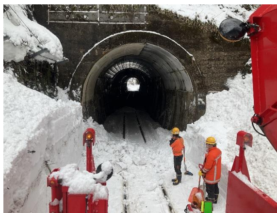
〈第五坂根トンネル入口付近〉
