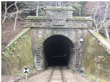
清瀧トンネル
