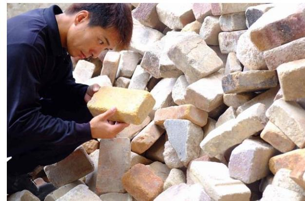
・運ばれたレンガを目利き力で選別し、ケレン作業によりモルタルをはずし形を整形し厳選されたレンガになる
