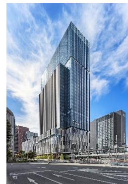
建物外観（JPタワー大阪）
