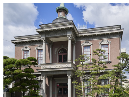
城西浪漫館(中島病院旧本館)
