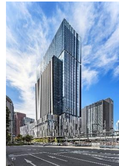
建物外観 (JP タワー大阪) イメージ
