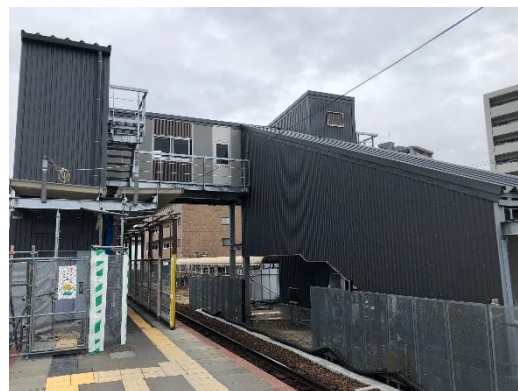
エレベーター付きこ線橋 (2024 年 2 月 15 日撮影)
