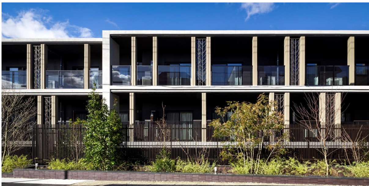
街並みと調和した建物外観とランドスケープ（南面）
