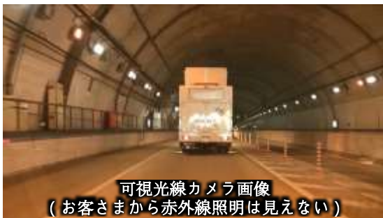
参考図-3 赤外線照明による点検状況(お客さまから見えない配慮)
