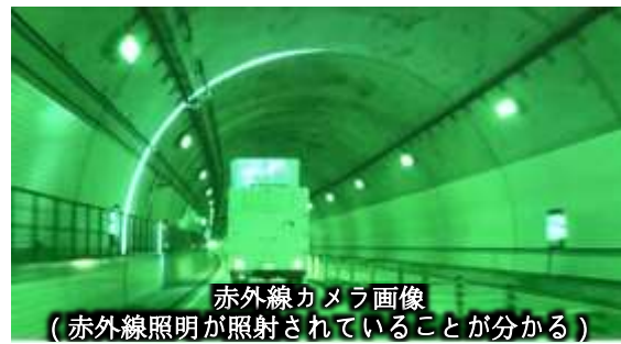
参考図-3 赤外線照明による点検状況(お客さまから見えない配慮)
