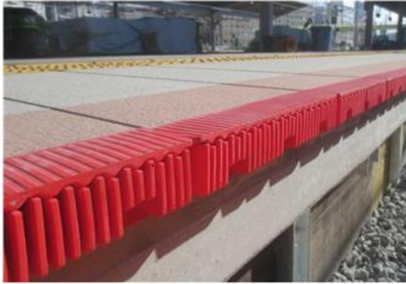
ホームと車両の隙間対策
