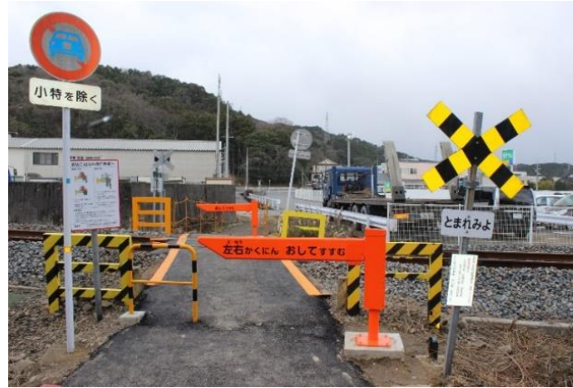
第4種踏切の踏切ゲート
