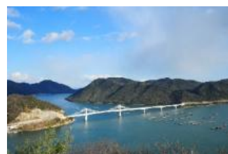
備前〇日生大橋
