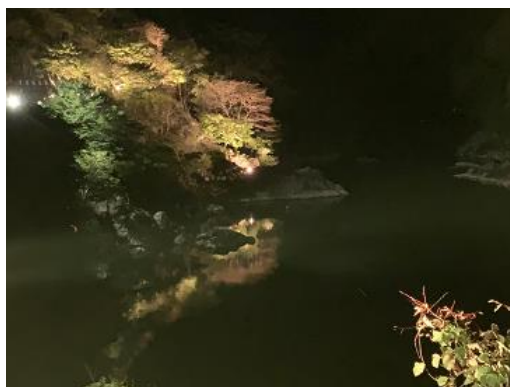
新設箇所の一例 【試験点灯】
