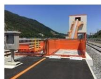
バラスト積み込み設備
