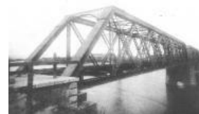
官設鉄道連絡線の淀川橋梁
