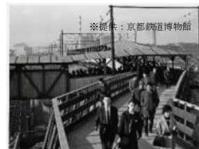
高架ホームへと渡る通路：西九条駅
