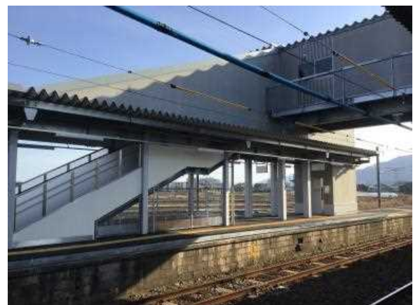
エレベーター付き新こ線橋全景 (現こ線橋より下関方へ移動します。)
