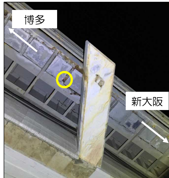
写真2 剥落箇所
