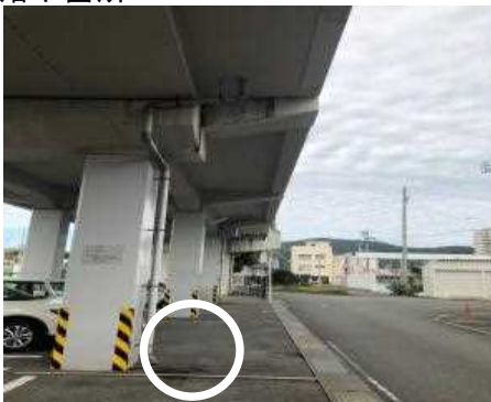
①落下箇所
