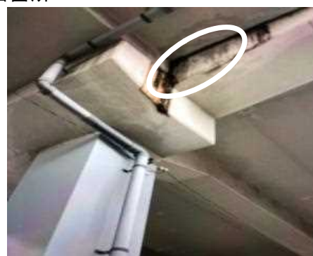
②脱落箇所
