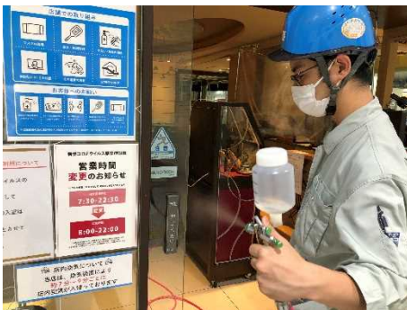
▲自動ドアのタッチボタンへの施工
