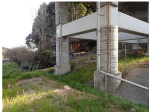
APAT工法による補強
