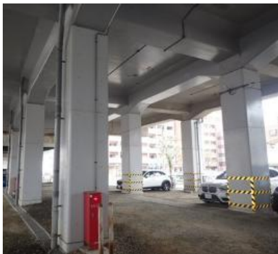
鋼板巻立て工法による補強
