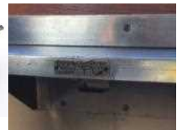
窓下の栓抜き
