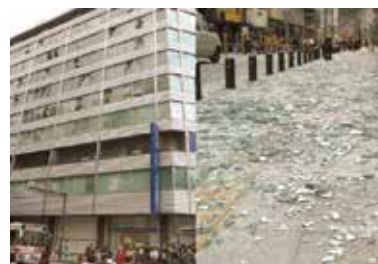
中央区天神の建物の被害
