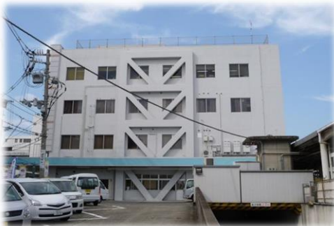
外部フレーム工法 (和歌山駅)
