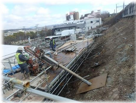
棒状補強材挿入施行中の状況
