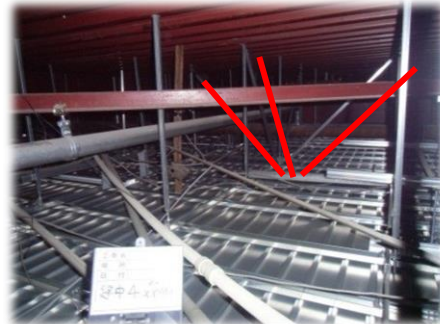
耐震天井下地設置
