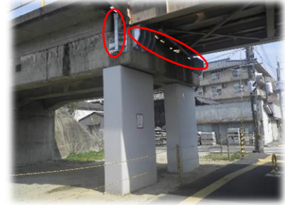
桁座拡幅・サイドブロック設置
