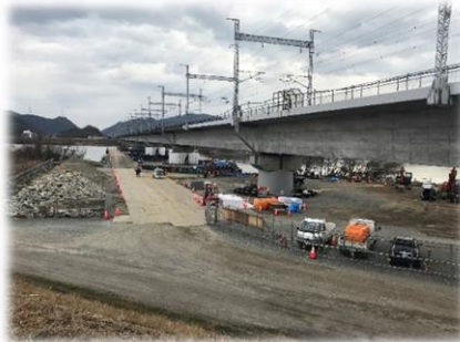
河川内工事の状況
