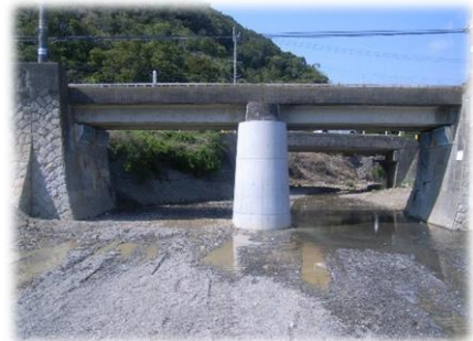
無筋橋脚補強 (紀勢線・コンクリート巻立て工法)
