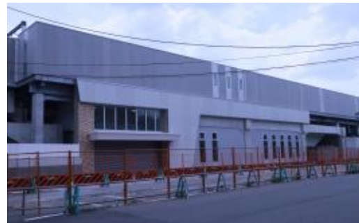
JR淡路駅 工事中的様子
