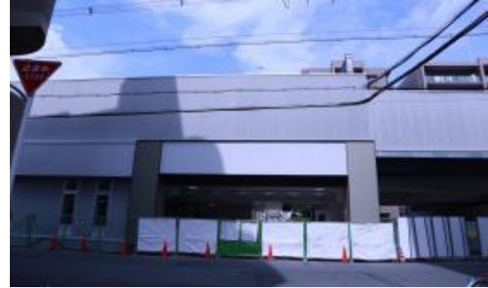
JR野江駅 工事中的様子
