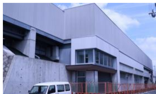
城北公園通駅 工事中的様子
