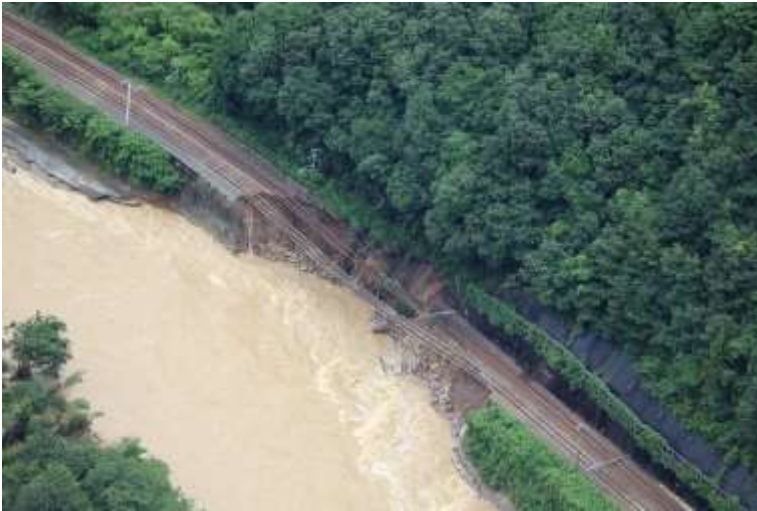
□写真① 山陽線 本郷～河内 駅間 盛土流出箇所 (7月7日撮影)
