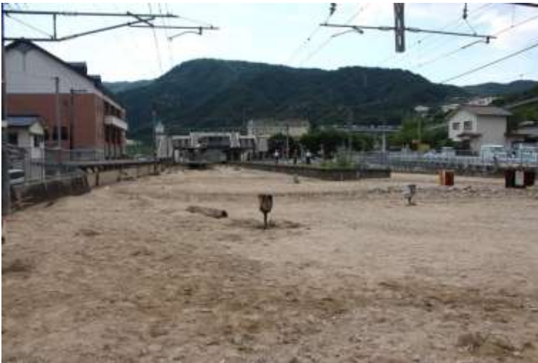
□写真② 山陽線 瀬野 駅構内 土砂堆積箇所 (7月9日撮影)
