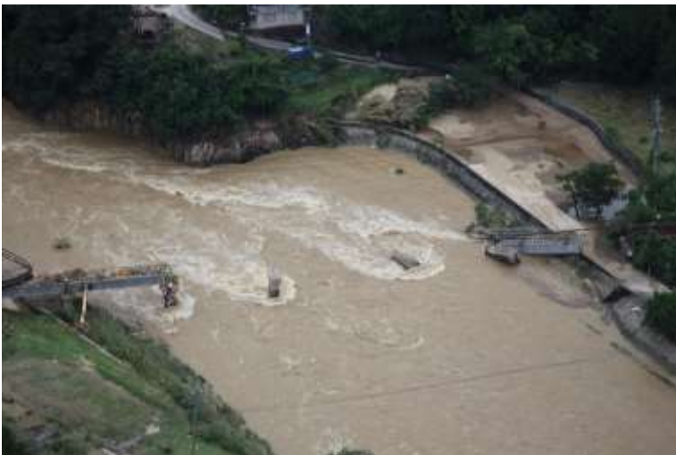
□写真③ 芸備線 白木山～狩留家 駅間 橋桁流出箇所 (7月7日撮影)
