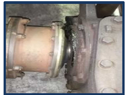
継手に油脂の付着
