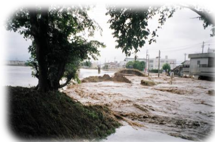
H16年7月福井豪雨による足羽川破堤 （福井市春日）
