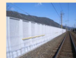
防風柵の整備
