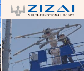
架線金具取替作業イメージ
