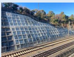
切土（きりど）施工例
