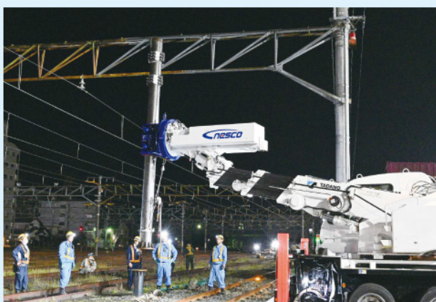
電柱を建てるハンドリング車
