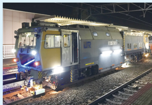
線路のゆがみを直す大型保守用車
