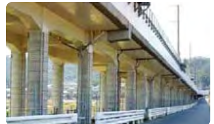
高架橋柱の耐震補強
