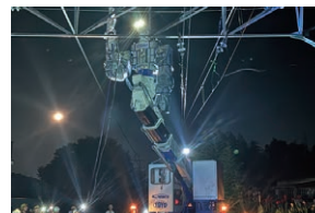
多機能鉄道重機
