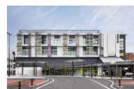
【西日本沿線】フコ西明石南館開業 (新改札口・駅前広場なども供用開始)
