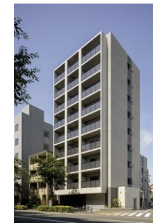
【成長エリア（首都圏）】 当社初の防音賃貸マンション 「ジェイグランコート中野」竣工
