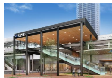
乗換結節点となる弁天町駅
