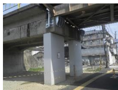
落橋防止対策
