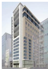
広島八丁堀NKビル
