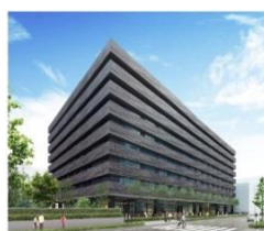
大阪北NKビル
