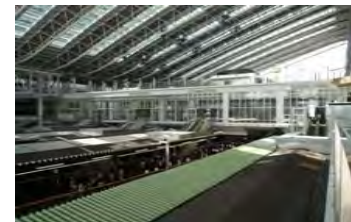
駅南北をつなぐ連絡通路
