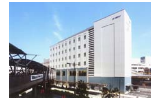
JR高槻駅NKビル (2009年6月開業)
