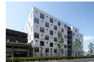
JR尼崎駅北NKビル (2009年9月開業)
