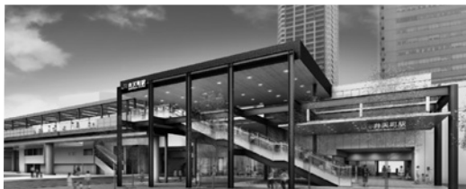
弁天町駅新駅舎
