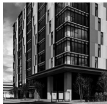
金沢第4NKビル
