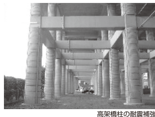
高架橋柱の耐震補強
