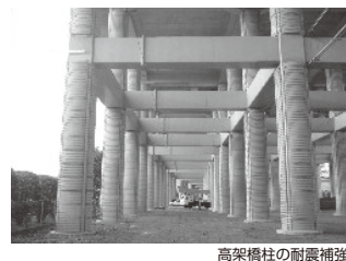
高架橋柱の耐震補強
