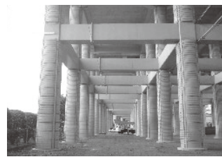
高架橋柱の耐震補強
