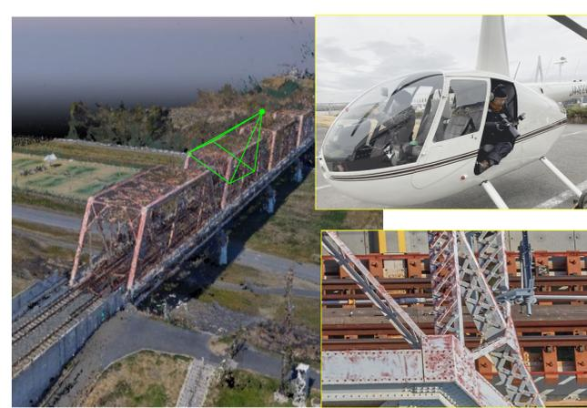
有人回転翼機により低空を超高解像度撮影することで構造物の状況を詳細に把握
