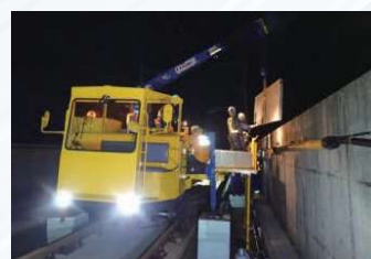
パネル吊上げ状況
